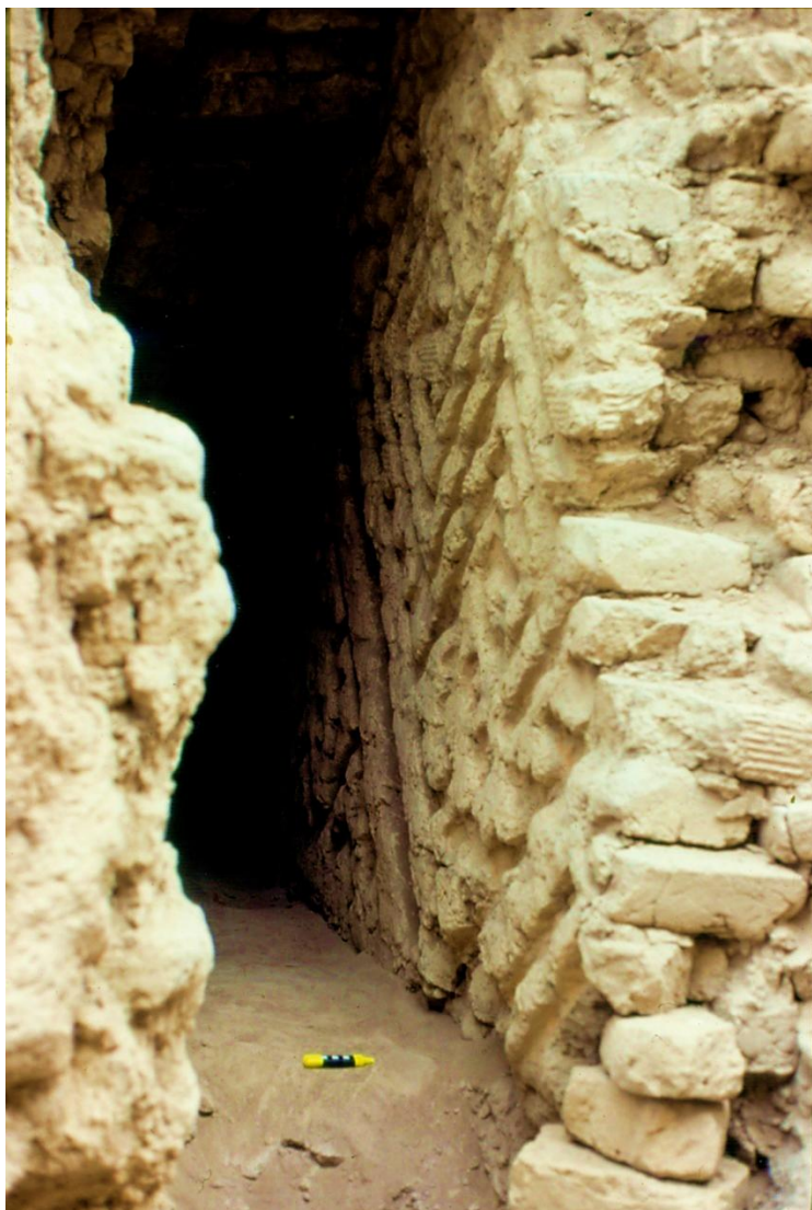
Figura 12. Relieves elaborados en la superficie de una estructura de adobes planos con improntas de gavera de tallos en la Huaca Cortada (Foto: C. Gálvez).
