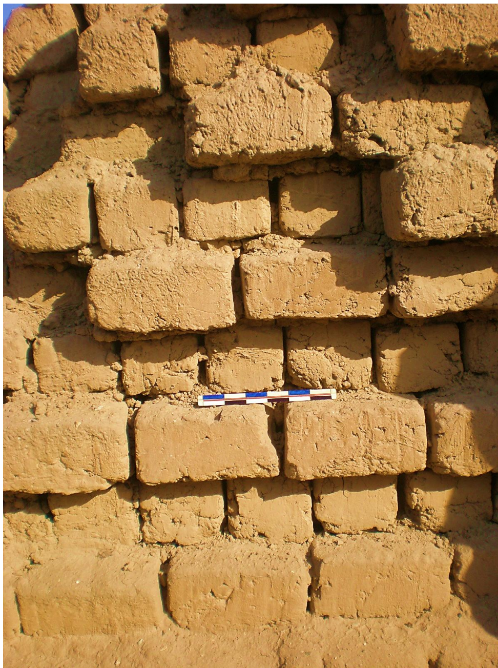
Figura 5. Adobes altos dispuestos de testa y canto, y canto en la muralla del sector El Castillo, Cerro Mocolope-Cerro Mayal (Foto: C. Gálvez).
