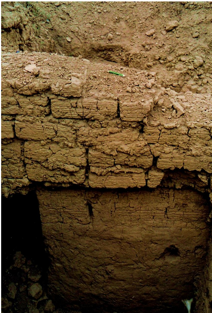
Figura 9. Adobes planos con impronta de gavera de tallos, dispuestos de testa y canto, en un edificio temprano de la Huaca Cao Viejo (Foto: C. Gálvez).
