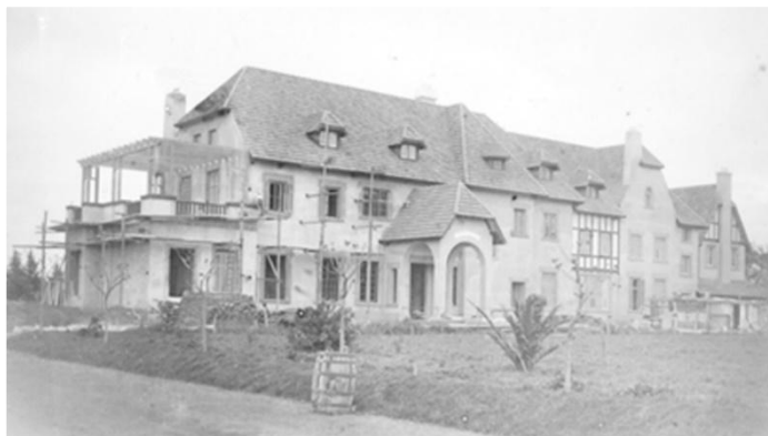
Imagen 1. Construcción del palacio Sans Souci con andamios y obreros trabajando
