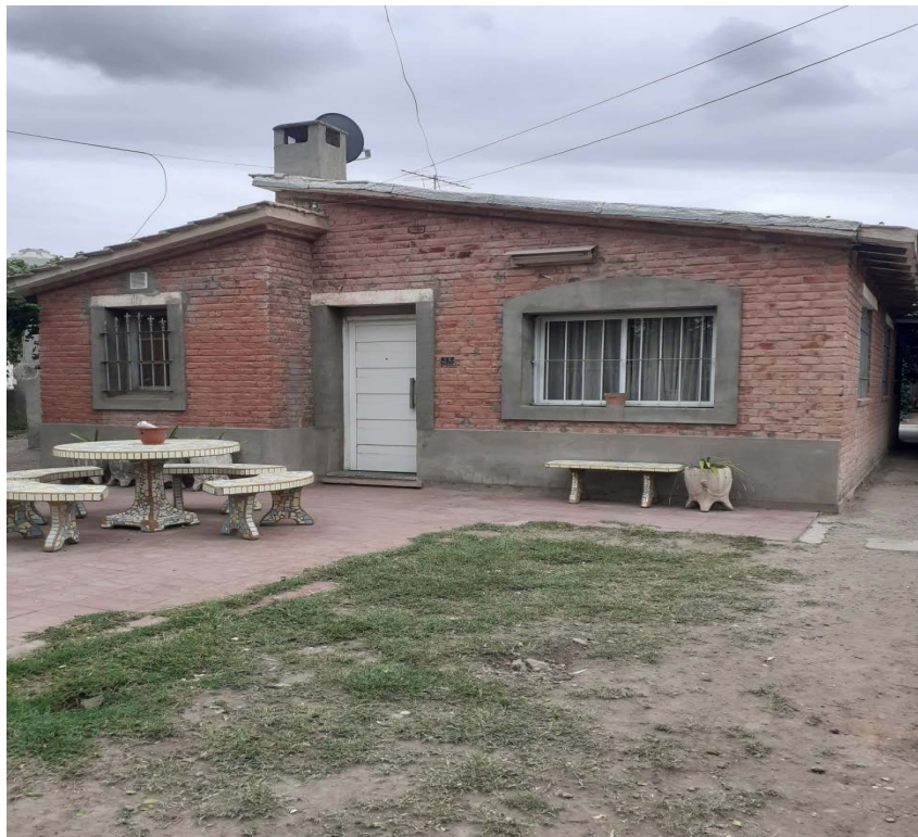
Figura N°3. Estado actual de Vivienda del Barrio Rawson
