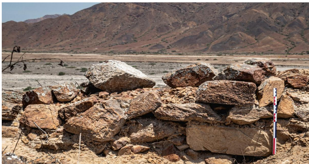
Figura 20. Muro occidental de la plataforma principal del sitio arqueológico La Calera, construido mediante disposición de bloques líticos de tamaño variable (fotografía: R. Pérez).
