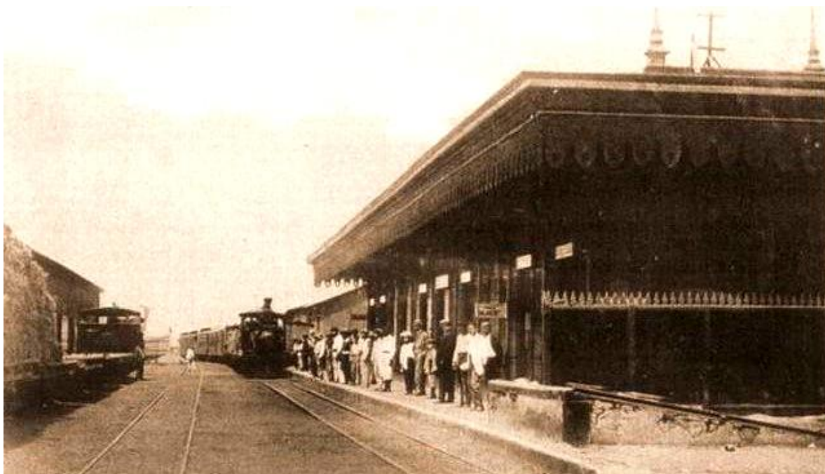
Figura 6. Estación de Trujillo (Fuente: solardelascalders.blogspot.com/2011/09/trujillo-antiguo.html )
