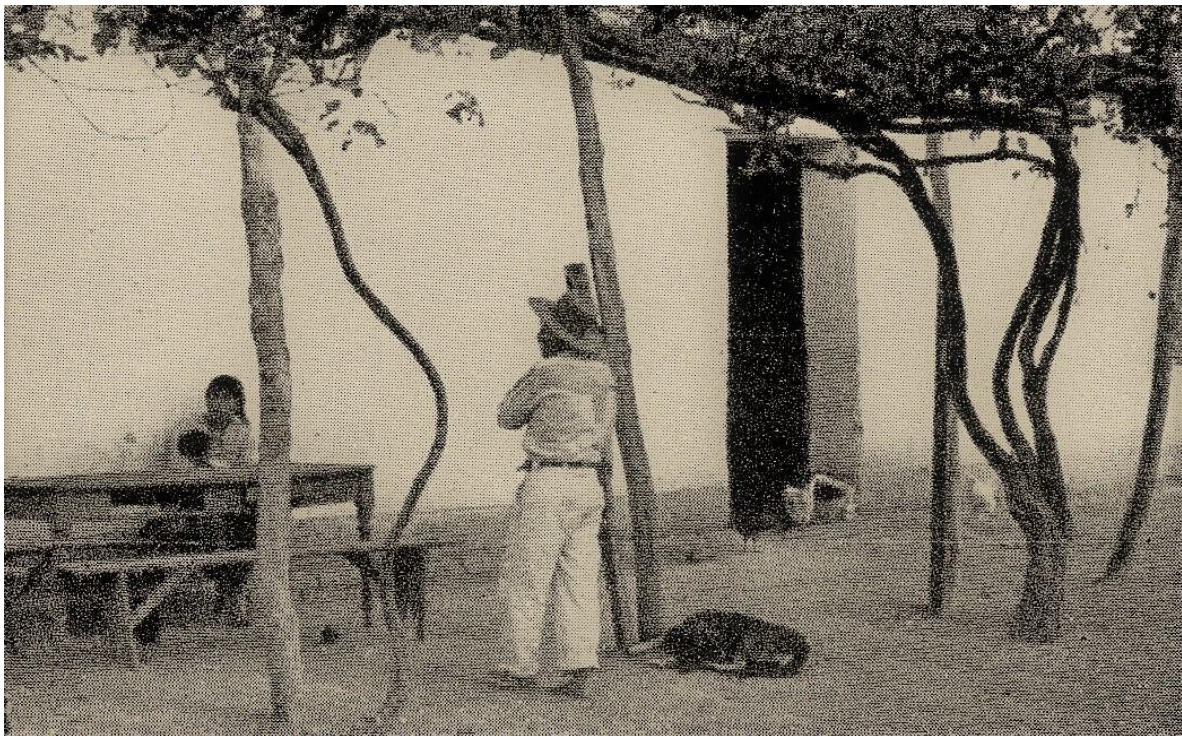
Figura 20. Casa rural con ramada en Moche (Fuente: Gillin, 1945, Lám. 13)
