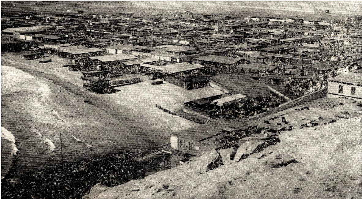
Figura 5. Puerto de Salaverry (Fuente: Junta del Cuarto Centenario de la Fundación de Trujillo, 1935, Fig. 8)
