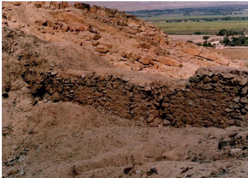
Figura 5. Arquitectura lítica en la cima de Cerro Cruz de Botijas, referente regional para la comparación de patrones constructivos en el valle medio de Chicama (fotografía: C. Gálvez).
