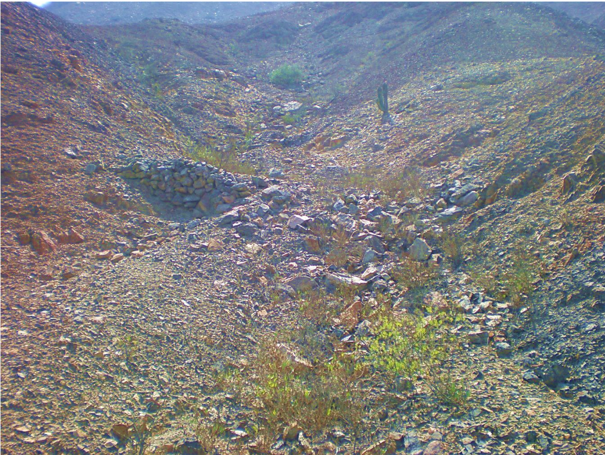
Figura 26. Muro de contención de tramo corto 2, en la ladera sur del Cerro San Antonio (Foto C. Gálvez) / Short section retaining wall 2, on the south slope of Cerro San Antonio (Photo C. Gálvez).
