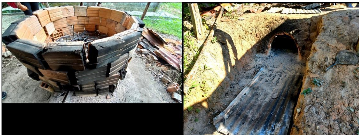
Figura 18. Hornos de Alejandro Canayo (paredes de ladrillos) y de Julio Ricopa (cámara excavada en tierra).
