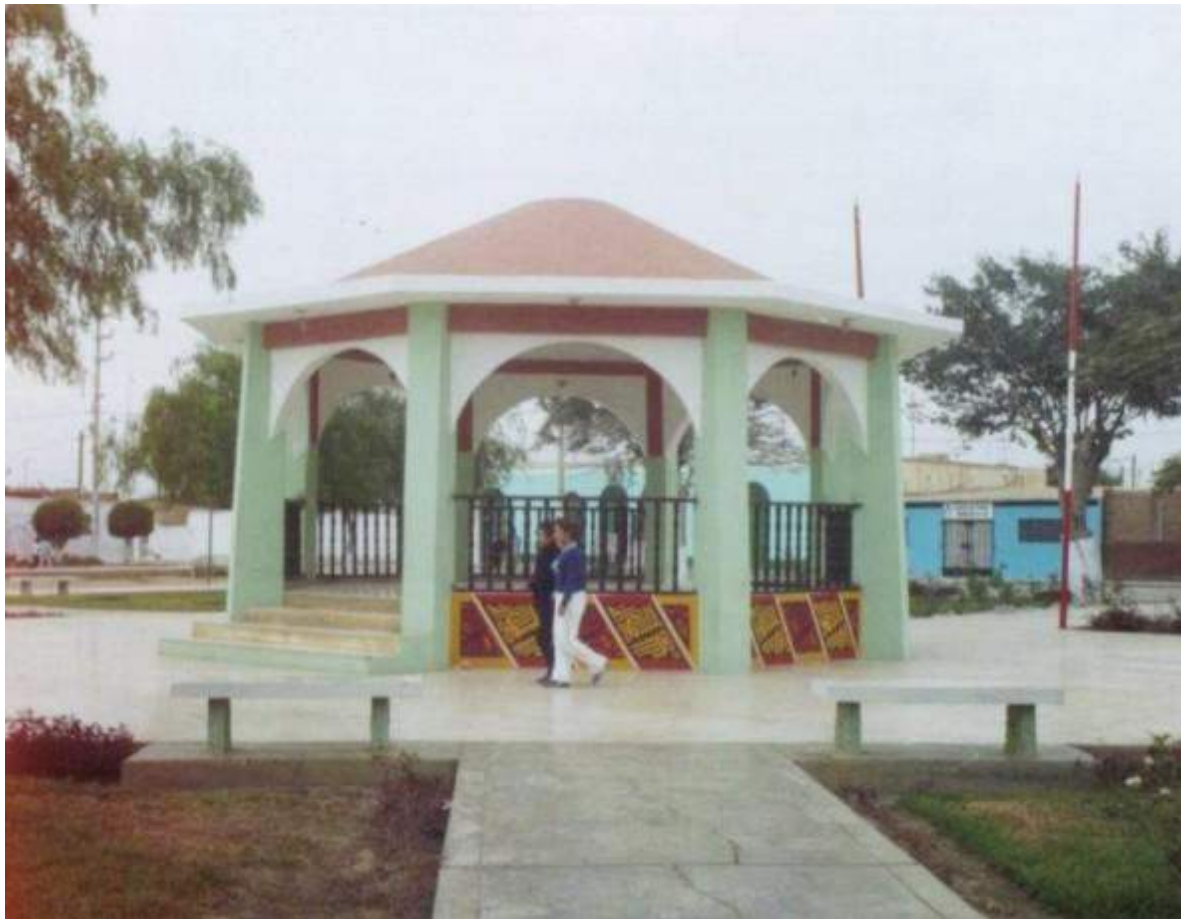
Figura 11. Plaza con estructura moderna que luce diseños de la iconografía mochica (siglos I-VIII d.C.) registrada en El Brujo. Hacia el fondo, el edificio de la municipalidad.
