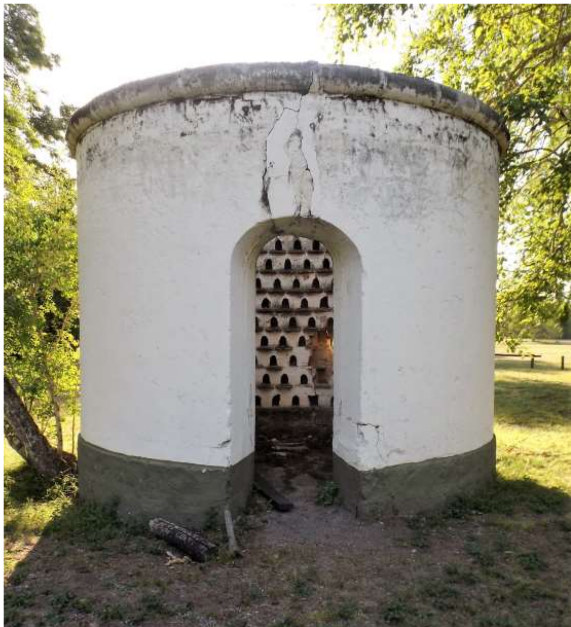
Figura 1: Palomar en El Palmar, Entre Ríos, de estructura cilíndrica.
