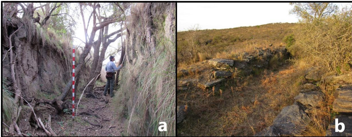
Figura 3. Acequia del Dique Antiguo: a) Tramo del cauce excavado, uno de los de mayor profundidad que se han conservado. b) Tramo del cauce con taludes laterales construidos con piedra sin cantear –esquistos- y tierra (Fotografías del autor).
