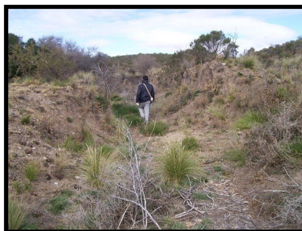
Figura 5: Cauce de la Acequia del Dique Antigo.
