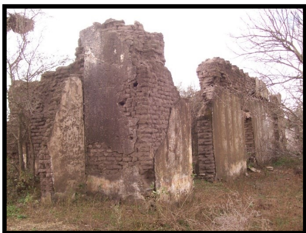
Figura 3: Edificio N°1, Casco Antiguo de Piedra Blanca.
