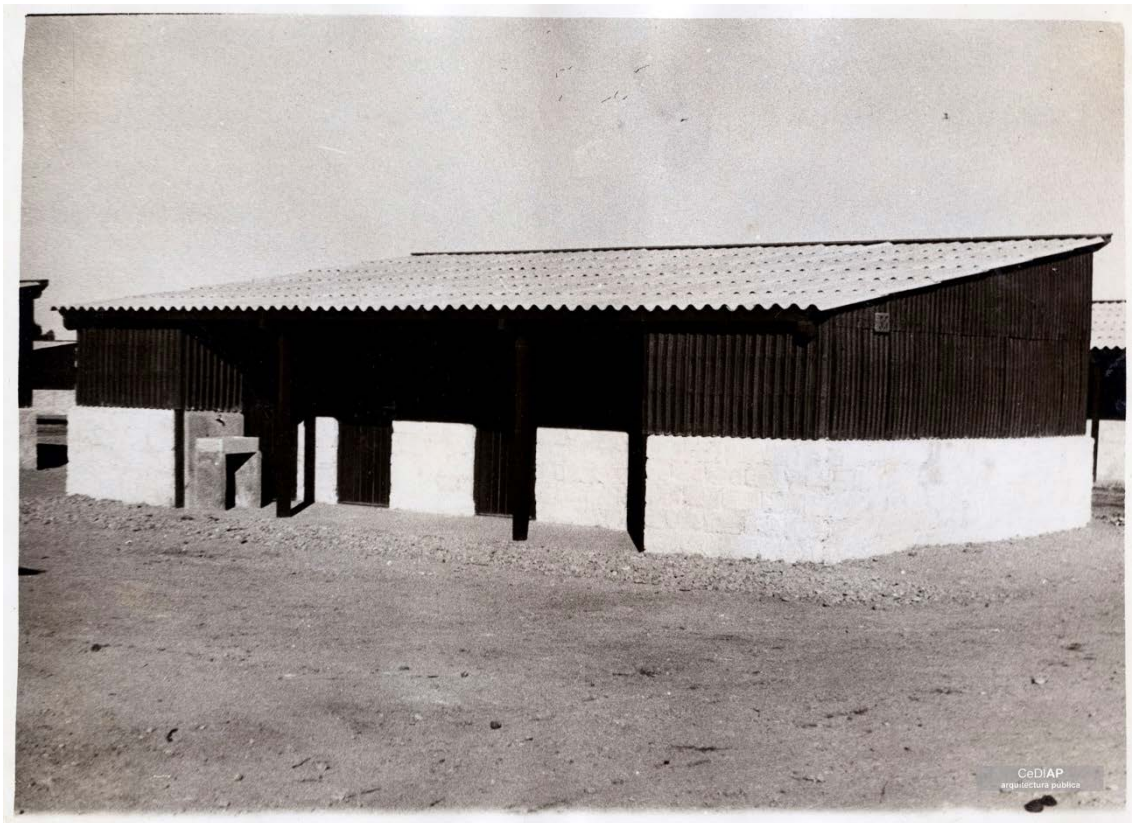
Figura N°4. Vistas de viviendas de emergencia. Casa de dos habitaciones con baño y cocina
