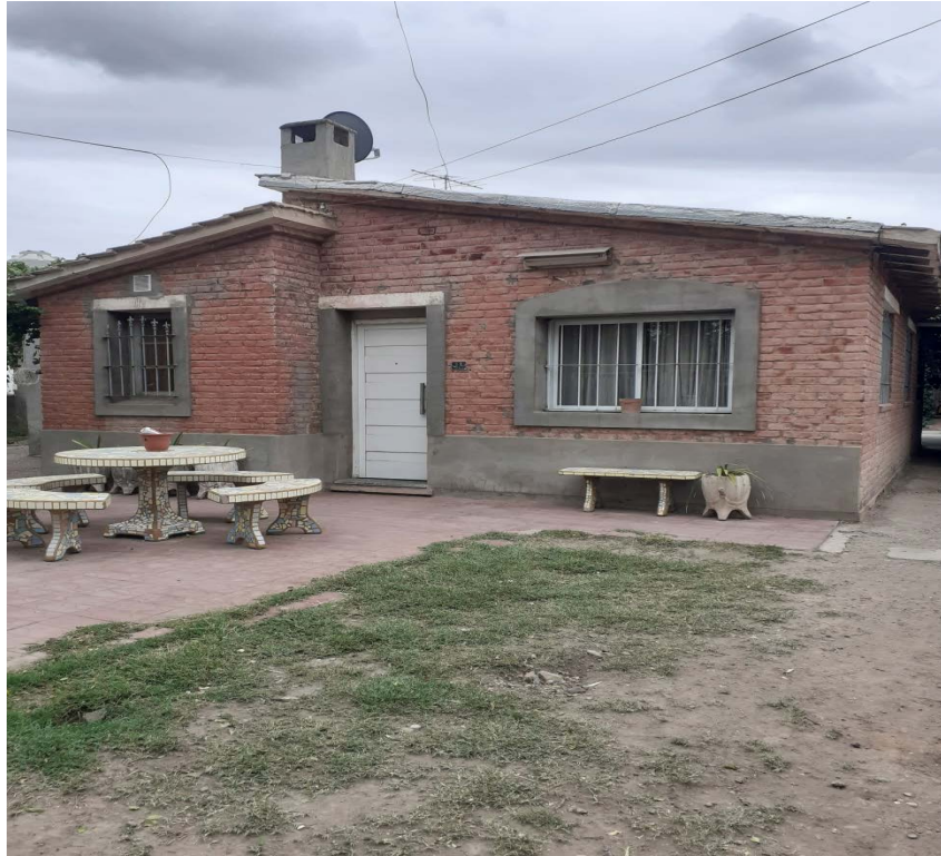
Figura N°3. Estado actual de Vivienda del Barrio Rawson
