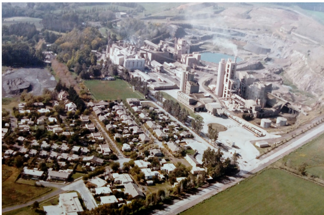
Imagen 3: Foto satelital de la villa obrera Von Bernard, empresa Calera Avellaneda S.A., año 1975 (Fuente: Archivo Histórico Municipal de Olavarría)
