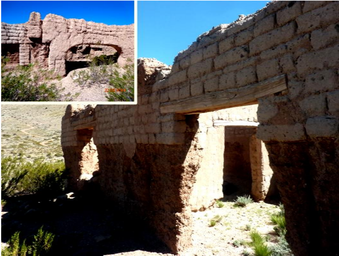
Figura 7. Detalles de la vivienda de la instalación ganadera de la Quebrada de Chita (Departamento Iglesia).
