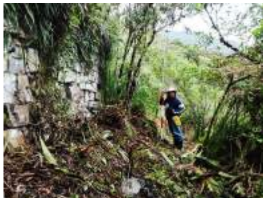
Figura 02: Proceso de levantamiento en parte de un muro prehispánico. El tipo de levantamiento mostrado en esta toma es en tiempo real.
