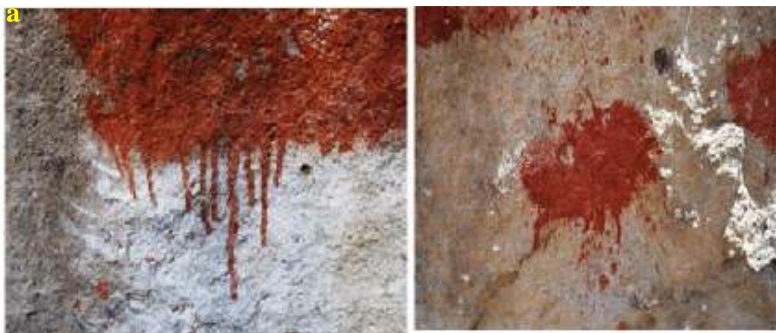
Figura 55 (a y b). Chorreras originadas por el empleo de mezclas pigmentarias muy acuosas
