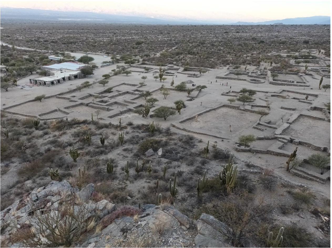
Figura 5: estructuras al pie del cerro. En la parte superior izquierda se puede apreciar el camino de ingreso, el estacionamiento y edificios modernos que cumplen diversas funciones (puestos de venta de artesanías y regionales, centro de interpretación y otros). Fotografía: Flavio Ribero (2024).
