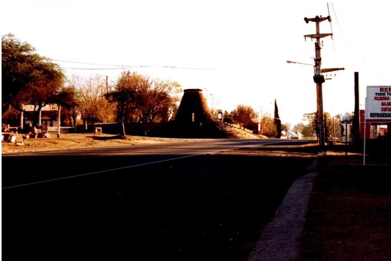
Figura 1: Horno “El Argentino”. En primer plano, la ruta nacional N° 38 que atraviesa los terrenos donde estuvo emplazada la fábrica de cales “La Primera Argentina”. Fotografía: Ana M. Rocchietti (2003).
